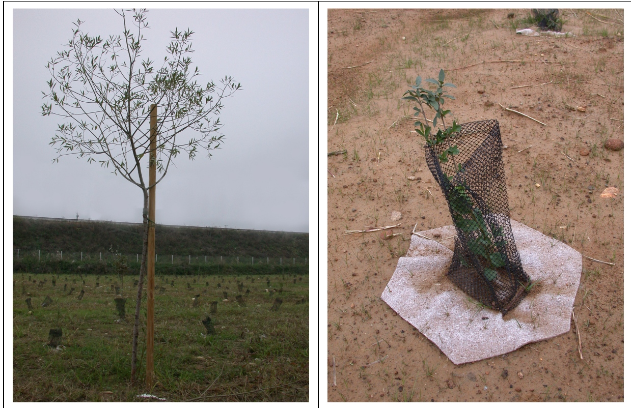
Figura 9: A sinistra piantumazione di una pianta arborea con posizionamento dell'apposito tutore in legno. A destra messa a dimora di un arbusto con il posizionamento del disco pacciamante e della rete di protezione.
